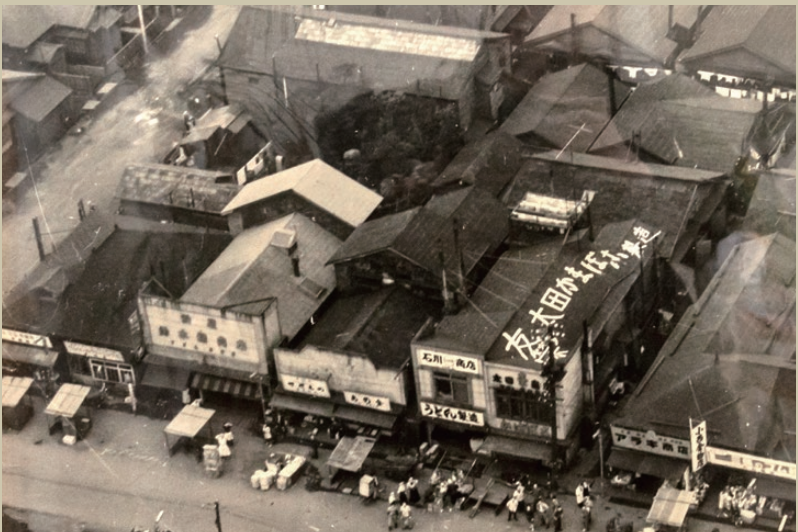
昭和30年代に撮影されたと思われる空撮写真。このときへりを探縦していたのが先代の幸次郎の兄。一方、幸次郎はこの撮影に合わせて「せっかくだから」と屋根にのぼって、ペンキで豪快に屋号と店名を書いた。
